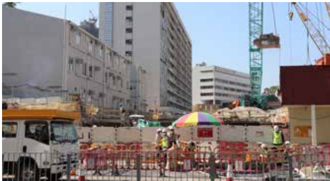
白色圍板封閉處為新車路入口。
